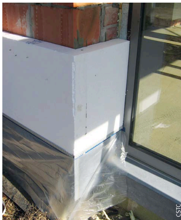
Fig. 112 Pose de l'isolant contre la bande d'étanchéité de manière à la comprimer.
