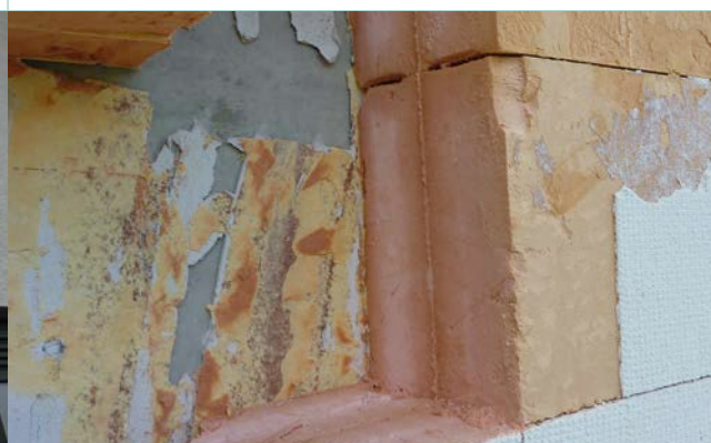
Apparition de la trame des joints entre panneaux d'isolation en surface de l'ETICS révélant l'instabilité dimensionnelle de l'isolant.
