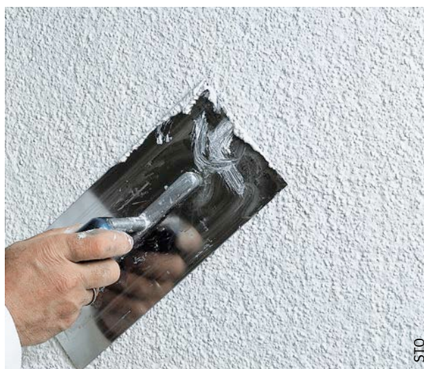
Fig. 136 Grésage d'un enduit de finition mince.
