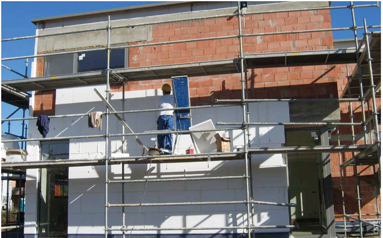
Fig. 13 Pose d'un isolant sur une façade extérieure.
