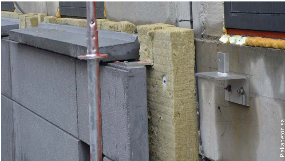
Fig. 84 Exemple de raccord à un mur coulisse.
