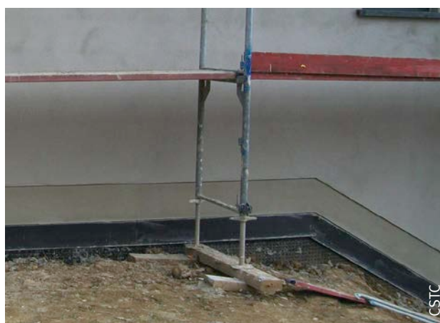
Fig. 96 Pied de mur horizontal et en pente.
