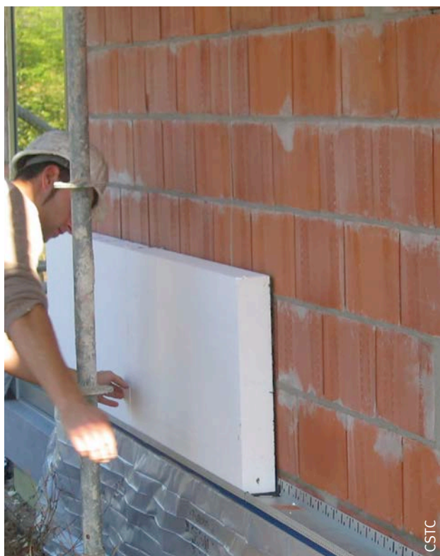
Fig. 100 Pose du premier panneau d'isolation inséré dans le profilé de socle.
