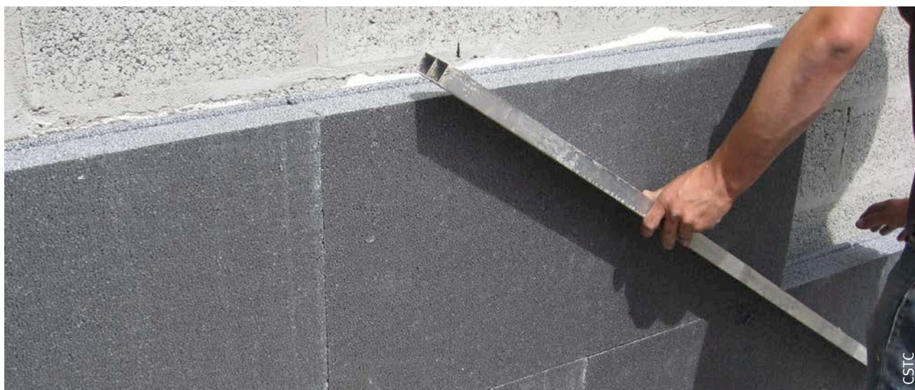
Fig. 2 Mise en œuvre des panneaux d'un ETICS.
