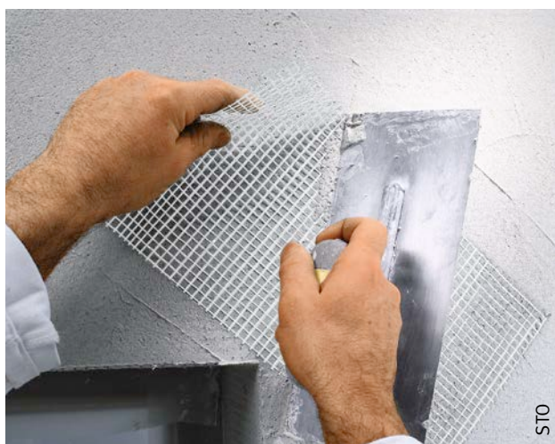
Fig. 127 Pose d'une bande d'armature de renfort dans l'angle d'une baie.
