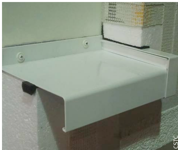
Fig. 108 Pose d'une bande d'étanchéité comprimée sur le pourtour des seuils (maquette de démonstration; châssis et son rejet d'eau non représentés).
