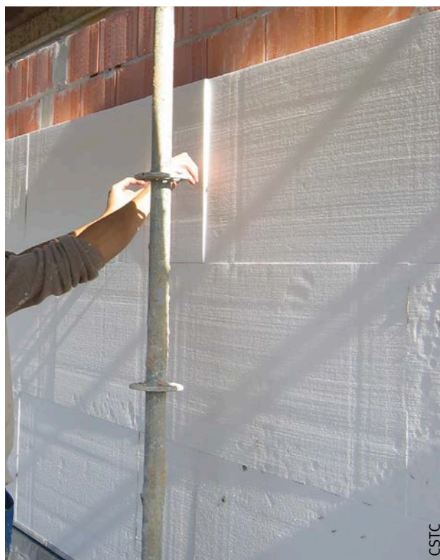
Fig. 101 Pose des panneaux à joints verticaux alternés.
