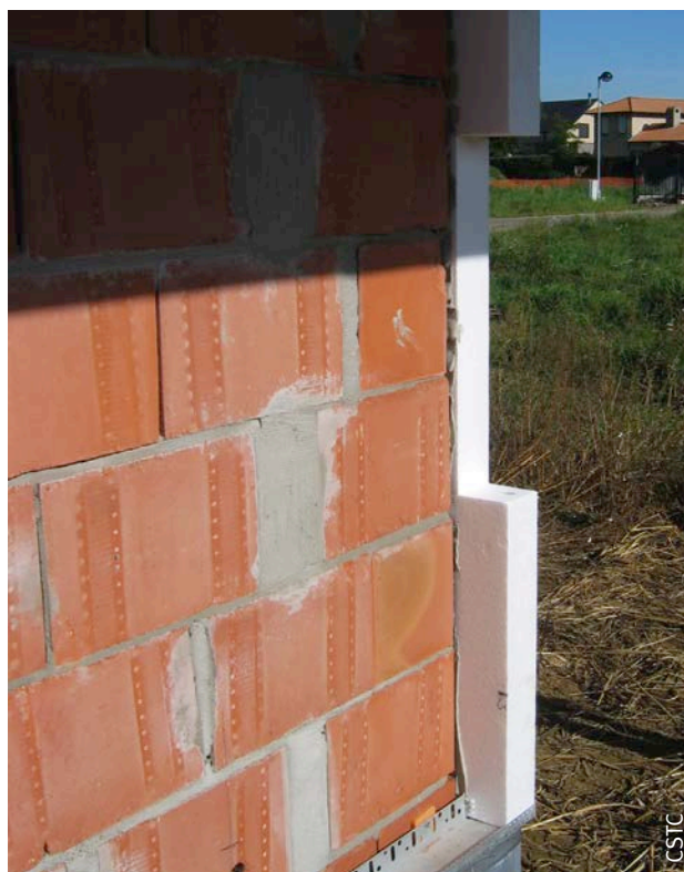
Fig. 103 Harpage dans les angles du bâtiment.
