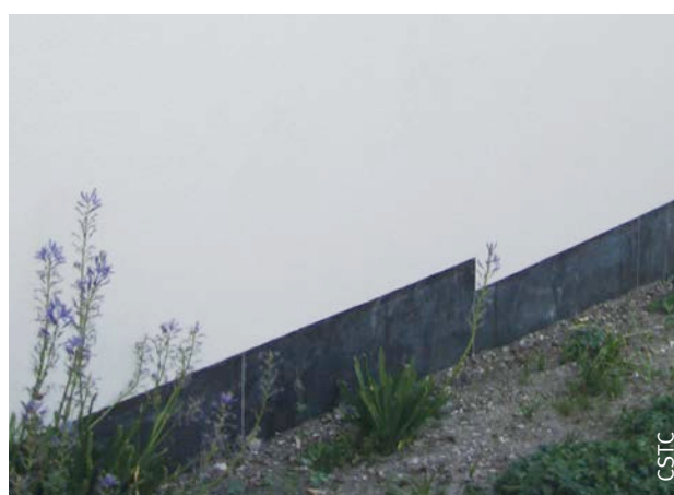
Fig. 98 Pied de mur en escalier.
