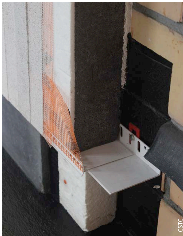
Fig. 46 Plinthe encollée sur l'isolant de socle.
