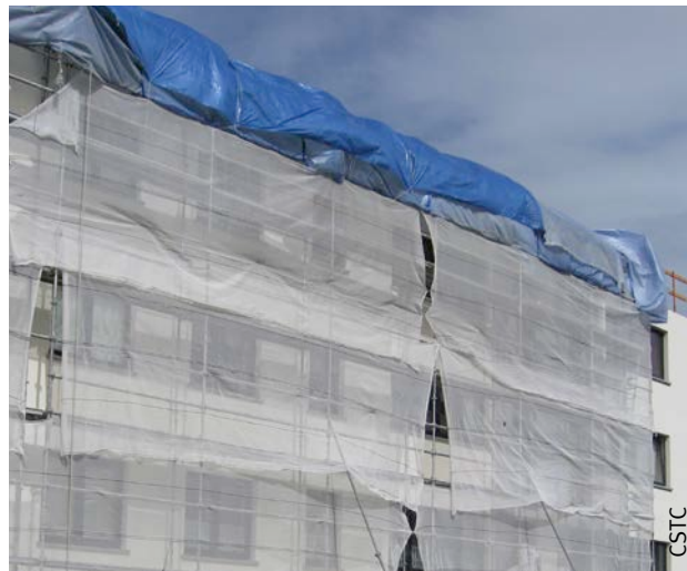
Fig. 94 Bâches de protection contre le soleil et le vent.
