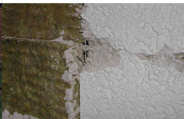
Apparition de la trame des joints entre panneaux d'isolation en surface de l'ETICS révélant l'instabilité dimensionnelle de l'isolant.
