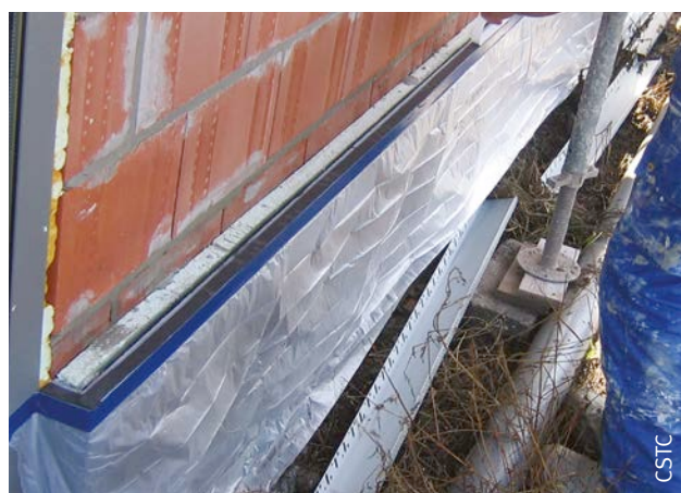
Fig. 95 Pose du préformé d'étanchéité sur la plinthe.
