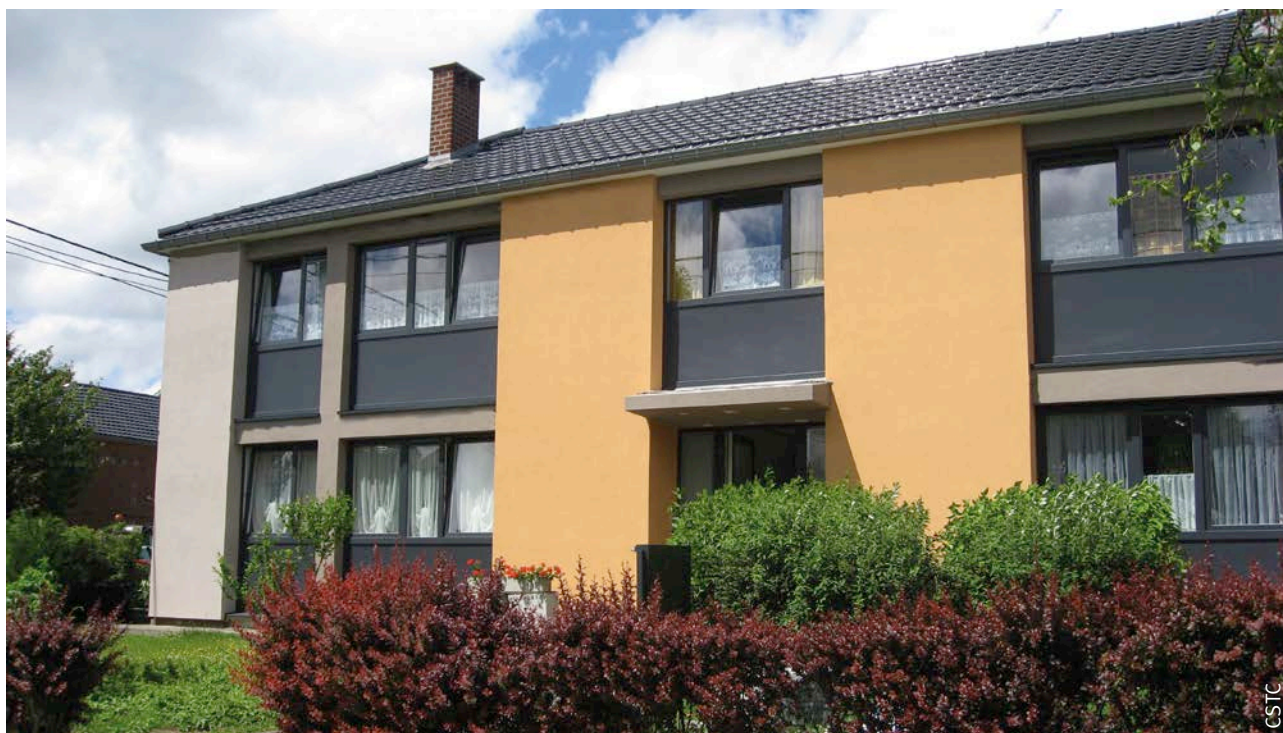
Fig. 1 Exemple de réalisation d'un ETICS.
