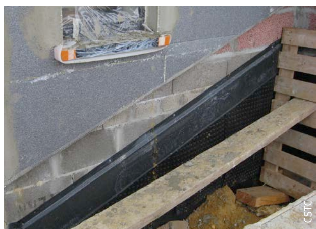
Fig. 97 Pied de mur en pente.
