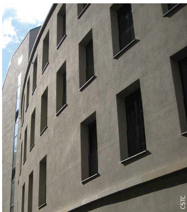
Fig. 51 Pose en battée (recommandée).
