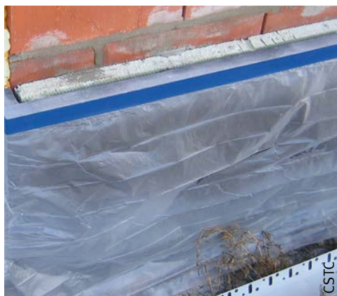
Fig. 92 Protection d'une plinthe.
