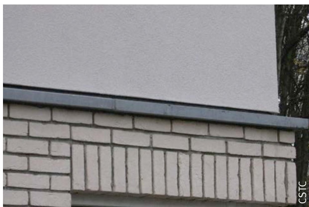
Fig. 82 Raccord d'un ETICS à un mur coulisse.
