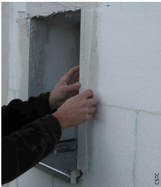
Fig. 124 Pose d'un profilé d'angle.
