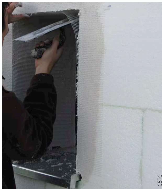
Fig. 126 Pose d'une armature de renfort pour assurer la continuité de l'armature dans l'angle rentrant.
