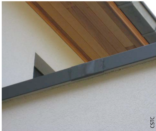
Fig. 67 Raccord à la rive d'une toiture plate.
