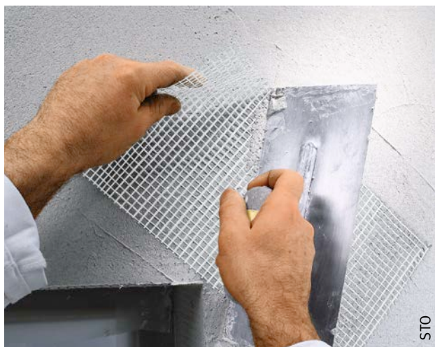
Afb. 127 Plaatsing van een strook wapeningsweefsel in de hoek van een opening.
