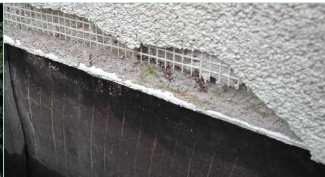
Scheurvorming en onthechting die te wijten zijn aan het te korte wapeningsweefsel dat niet verbonden is aan het startprofiel.
