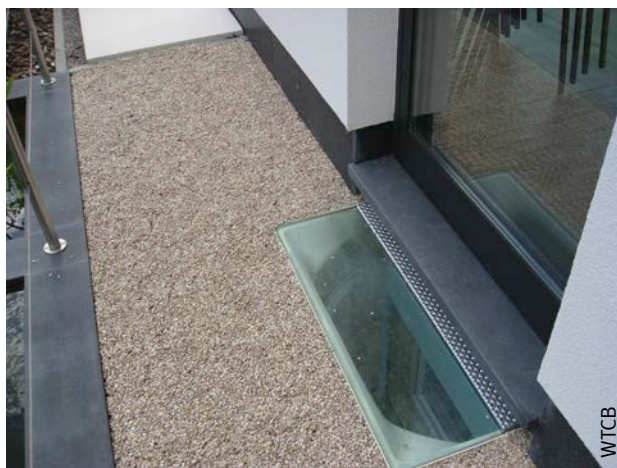
Afb. 44 Muurvoeten die uitgevoerd werden volgens de specifieke uitvoeringsbepalingen voor ETICS.
