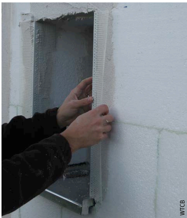
Afb. 124 Plaatsing van een hoekprofiel.
