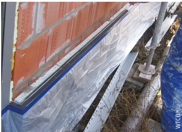
Afb. 95 Plaatsing van een zwelband op de plint.
