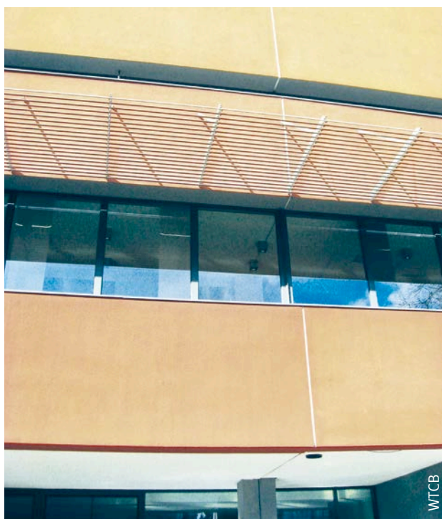
Afb. 87 Bewegingsvoegen aan het oppervlak van een ETICS.
