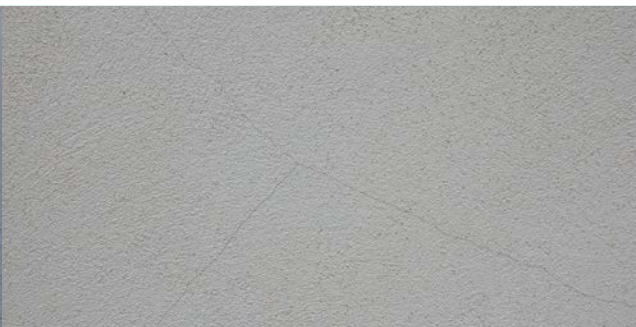
Scheurvorming in het minerale pleister (krimp) door de bindings- en de verhandelingsvoorwaarden en de eigenschappen van het pleister.
