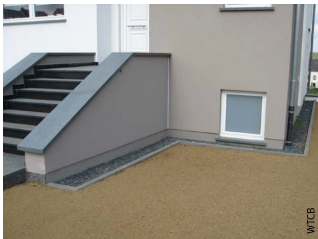
Afb. 44 Muurvoeten die uitgevoerd werden volgens de specifieke uitvoeringsbepalingen voor ETICS.
