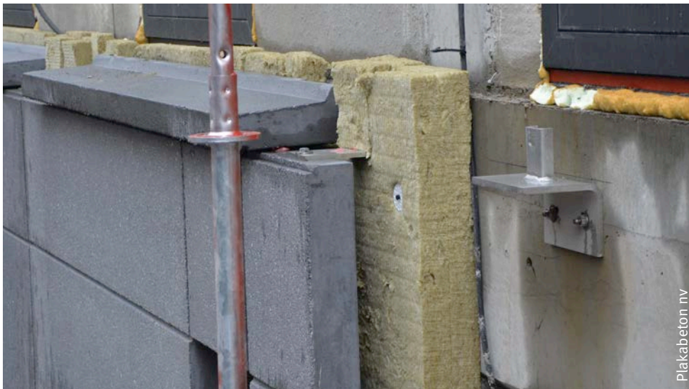
Afb. 84 Voorbeeld van een aansluiting met een spouwmuur.
