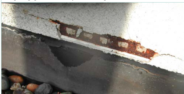
Corrosie van een startprofiel (ongeschikt vanwege de afwezigheid van een druiplijst) in gegalvaniseerd staal.
