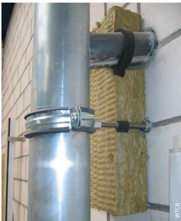
Afb. 111 Plaatsing van een zwelband (rugvulling) aan de aansluiting tussen de isolatieplaat en de doorboring van het ETICS.
