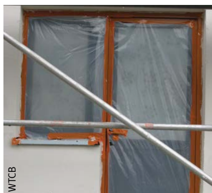
Afb. 93 Bescherming van een raam en een deur.
