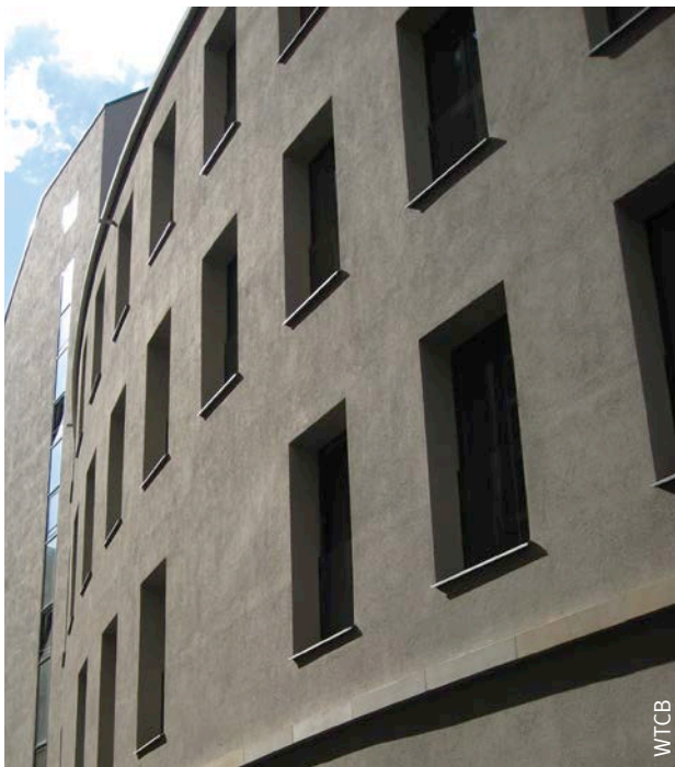
Afb. 51 Plaatsing in neg (aanbevolen).
