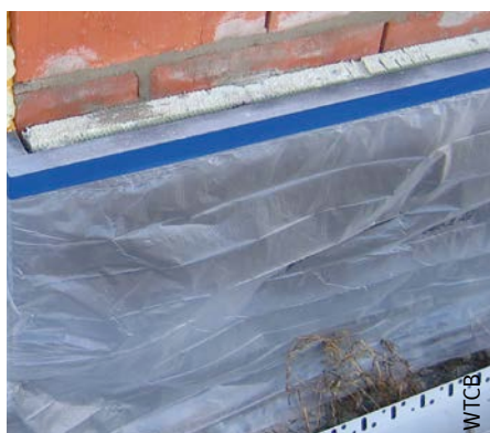
Afb. 92 Bescherming van een plint.
